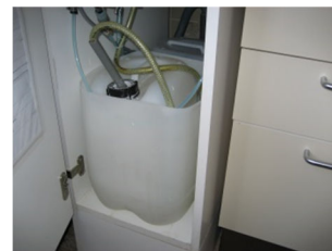
Vloeistoffen opslaan in lekbakken
